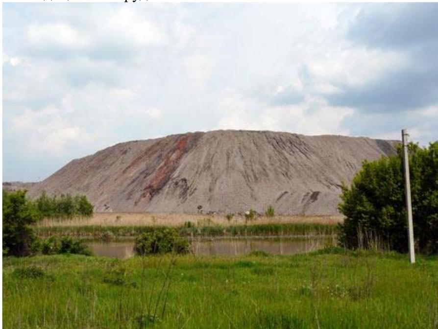
*Рисунок 1. Рекультивированный отвал уранодобывающего предприятия*
